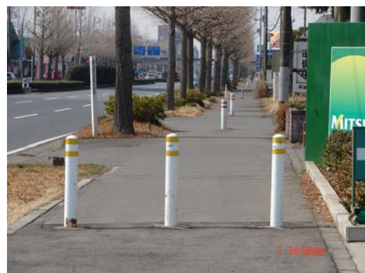
写真6 狭い車止め柵間隔。土浦学園線小野崎地区
