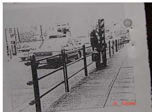
写真10 歩車道境界の縁石位置のポール横棒を渡したフェンス。笠間市
