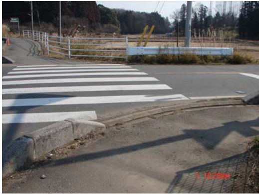
写真1 歩道端の無用なバリヤー。島名十字路から面野井への谷田川付近
