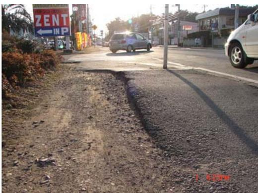
写真5 進行方向に平行な段差。国道354、ヤマダデンキ近くの歩道
